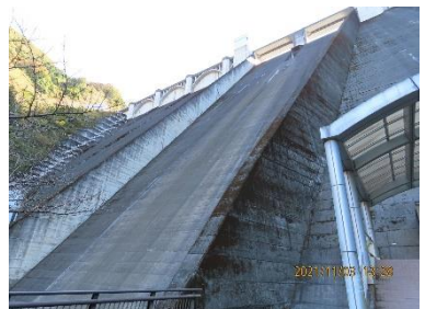
堤体を見上げる
